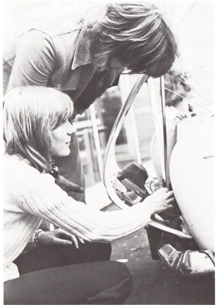
Abb. 3.18: Schüler wechseln eine Scheinwerfer-Bilux- Lampe aus
