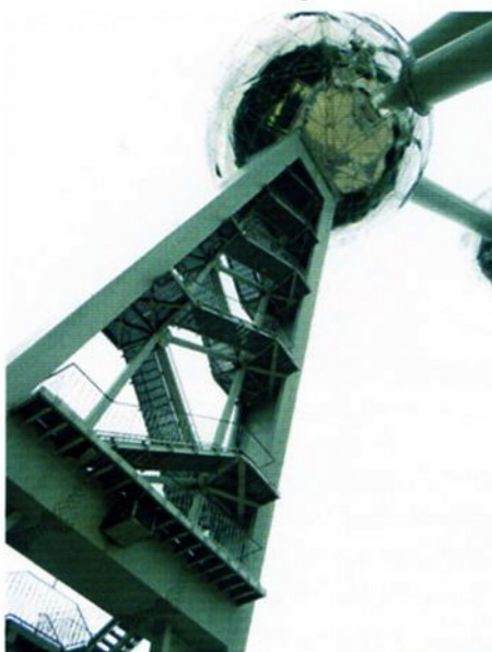
Einzelheiten des Treppenhauses, das mit der Stütze jeder Außenkugel verbunden ist. Eigenes Foto; Sommer 2013.
