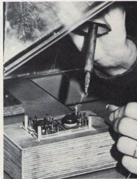
3. Manch zusätzliche Lötarbeit von Hand ist notwendig für die einwandfreie Funktion
